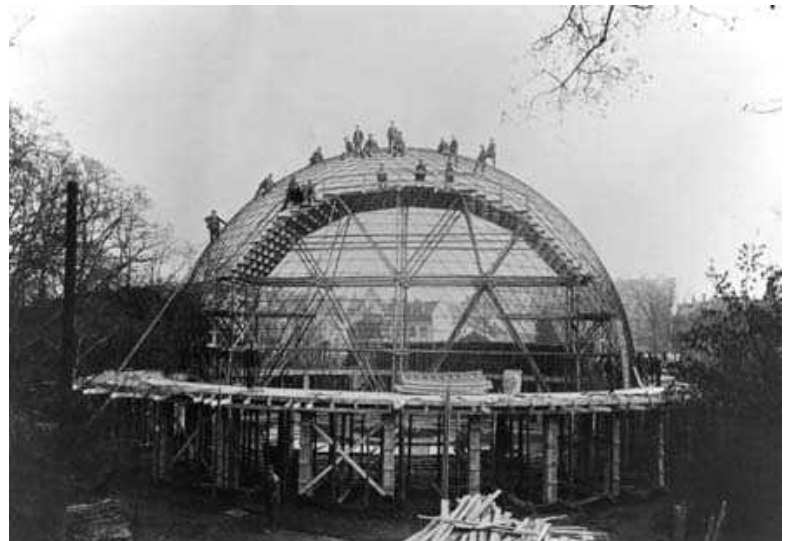
la construction du dôme du Deutsche Museum
